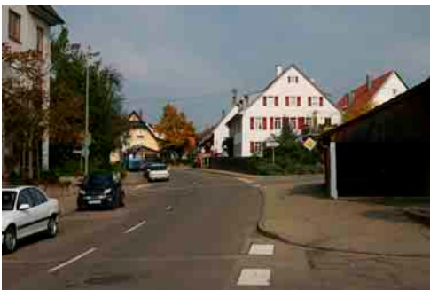
Einmündungsbereich Hauptstraße - Lautergasse
