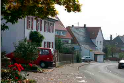
Bereich südlich der Engstelle Nord
